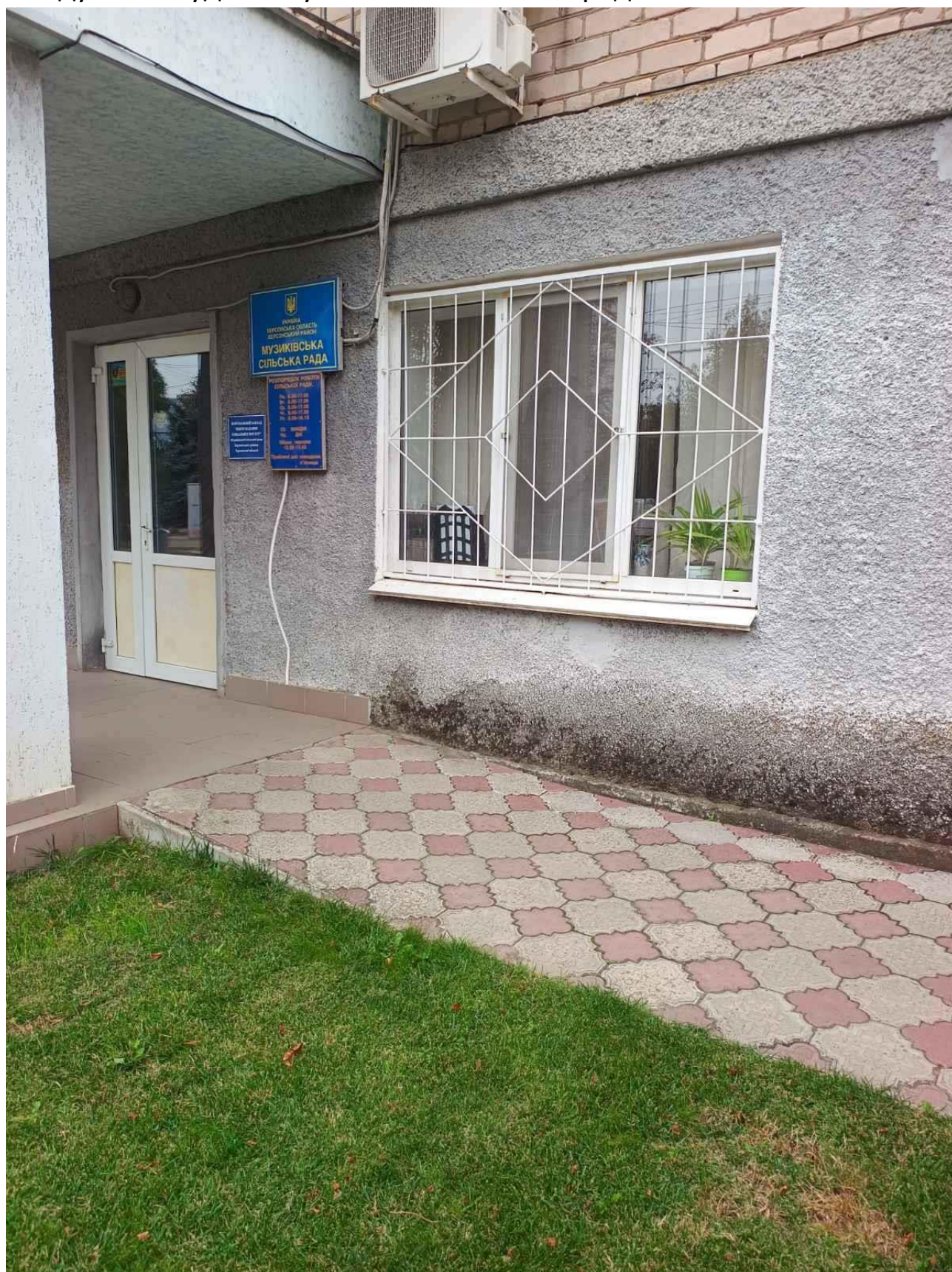
Пандус біля будівлі Музиківської сільської ради
